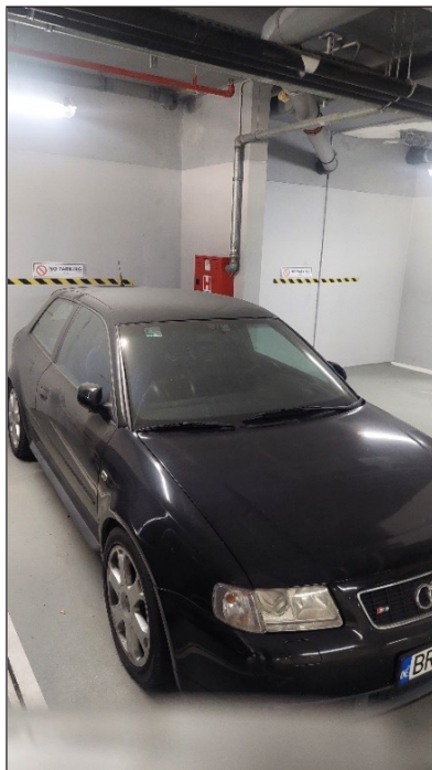
Slika 1. Nepristupačna hidrantska pozicija
