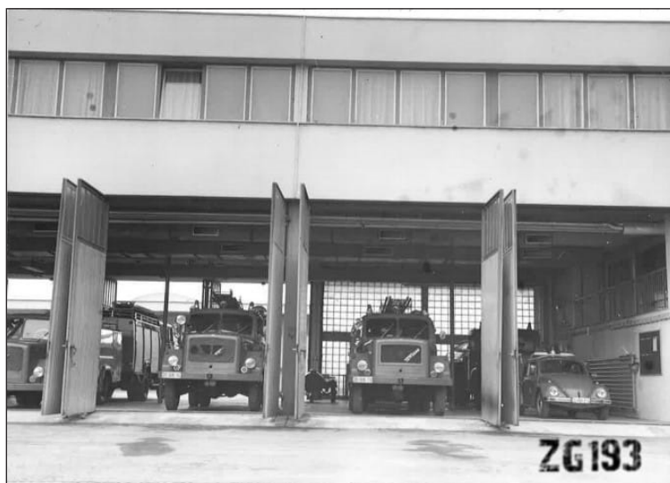
Garaže JVP Zagreb, Ispostava Žitnjak 1975. (arhiva JVP Zagreb)
